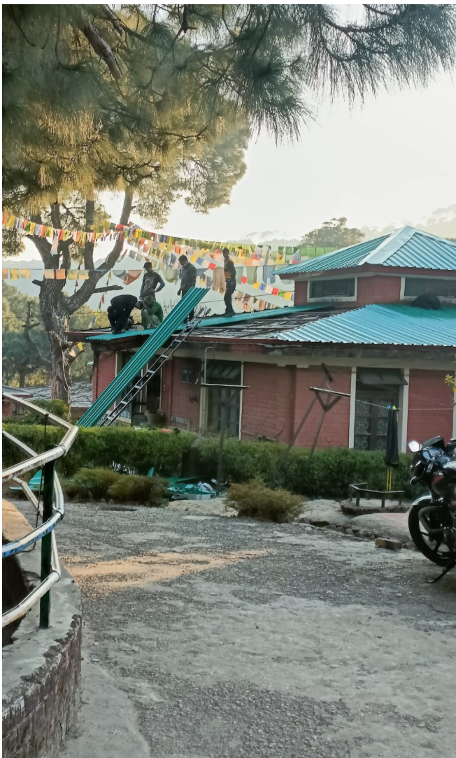
Installation de toit en tôle sur plusieurs logements dans les TCV de Gopalpur et Suja
